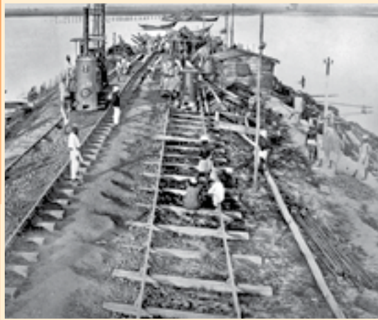
Bajo el dominio británico, se construyeron miles de millas de vías férreas en la India. Aquí, los trabajadores construyen el ferrocarril de Bengala Oriental alrededor de 1870.
